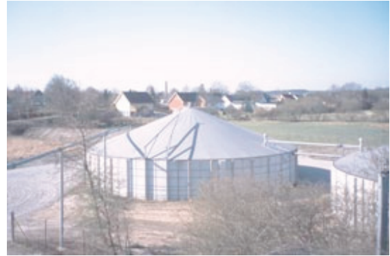
Figura 4.17. Planta de digestión anaerobia en una explotación ganadera
